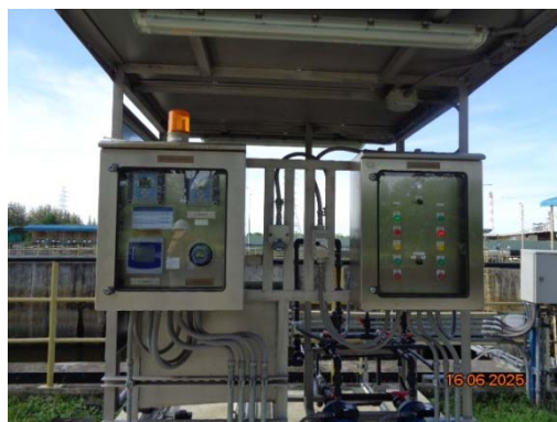
รูปที่ 16 ระบบตรวจวัดน้ำทิ้งแบบอัตโนมัติ
