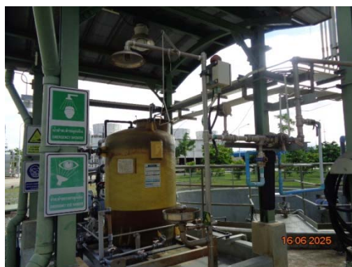
รูปที่ 36 อ่างล้างตาและร่างกายฉุกเฉิน
